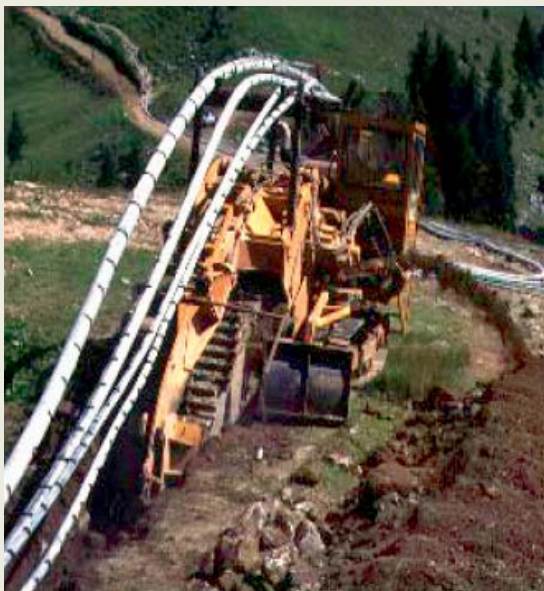
Izkop in polaganje cevi direktnega odvajanja odplak s pomočjo freze Arhiv Franca Maleinerja
