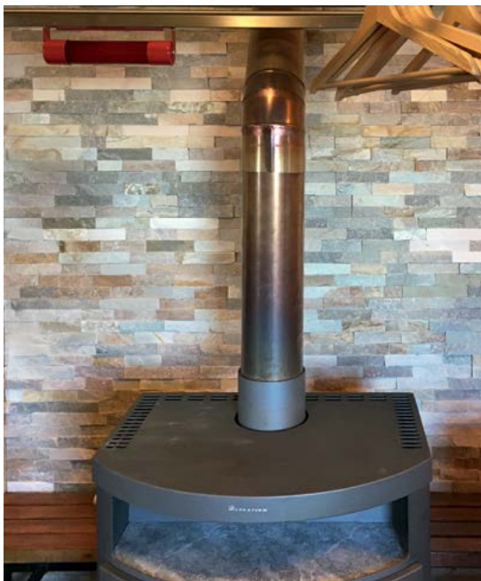
Gasilna ampula pri kamini v koči na Poreznu Arhiv PD Cerkno
