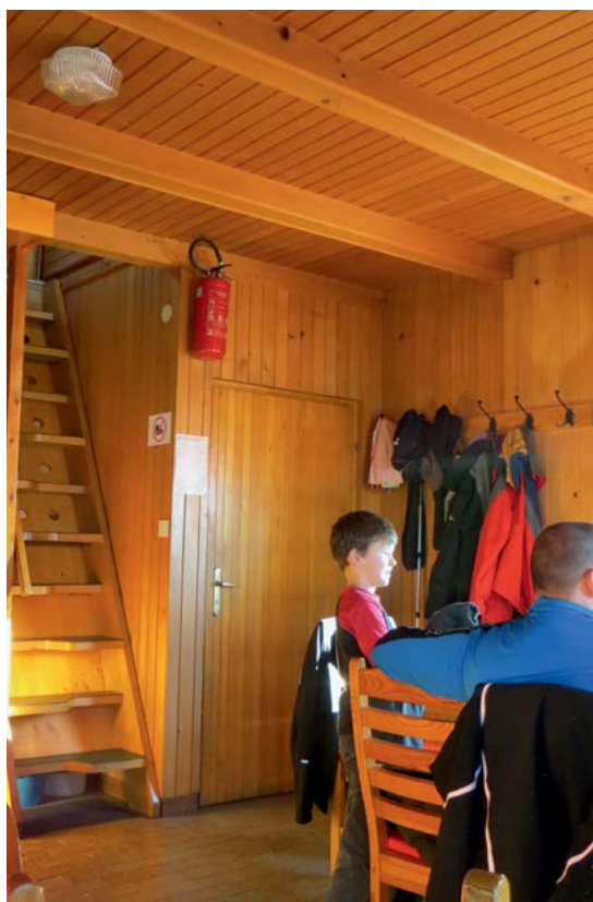
Previsoko montiran gasilni aparat v Planinski koči pri Sveti Ani na Mali gori Arhiv Zdenka Zupana
