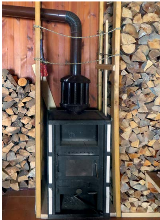
Veliko peči je starih oziroma so prostori, v katerih so postavljene, neustrezni – ponekad so premajhni, ali pa se okoli njih nahajajo gorljive snovi, kot je razvidno s slike: skladiščenje drv ob peči v koči Draga Karolina na Snežniku. Arhiv Zdenka Zupana
